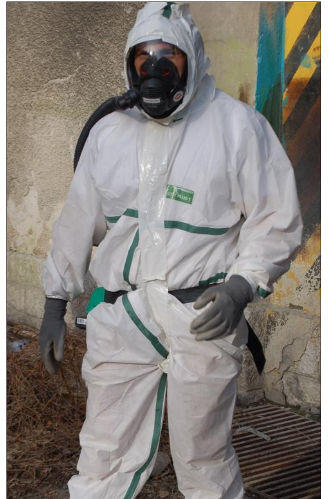
Le public n'imagine pas toute l'installation modulaire nécessaire à une opération de désamiantage. Archives photo Le DL/Audrey LUNGO
